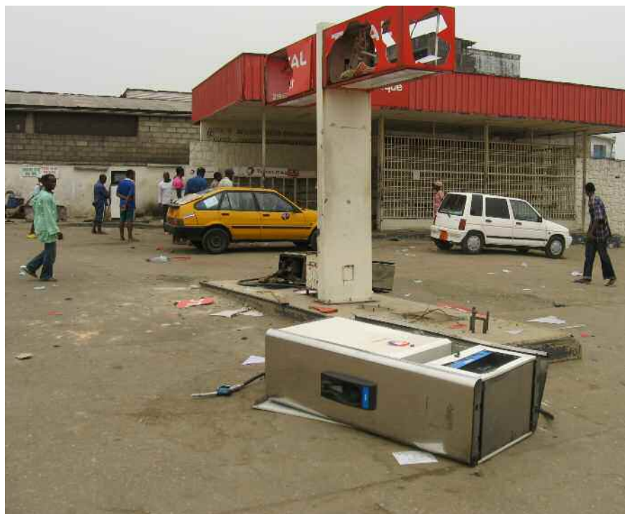
STATION SERVICE DÉTRUITE À DOUALA
